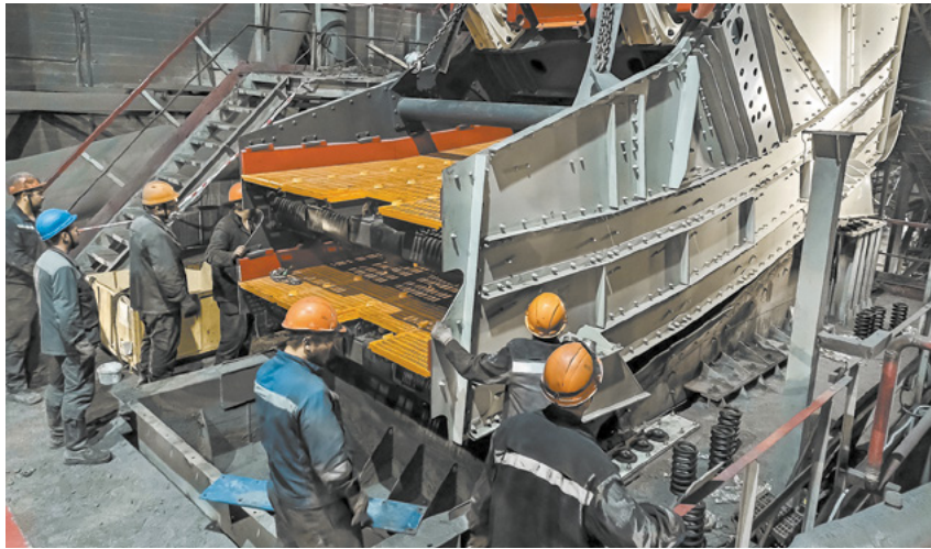
Масштабные ремонтные работы прошли на КМАруде.
