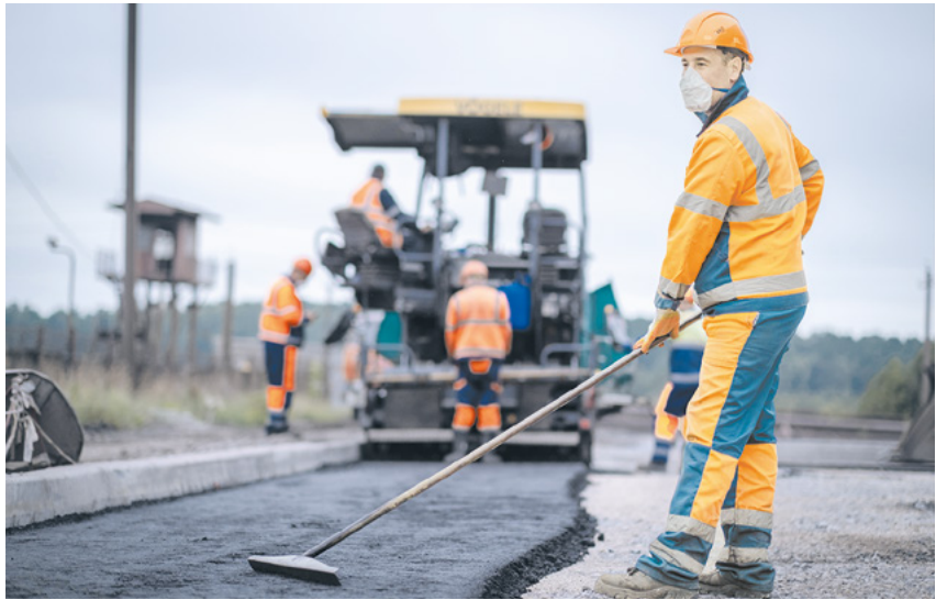
На Тулачермете обновили дорожное покрытие.
