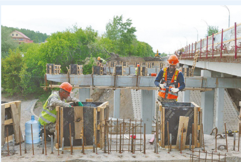
Работы по обновлению моста идут в штатном режиме.
