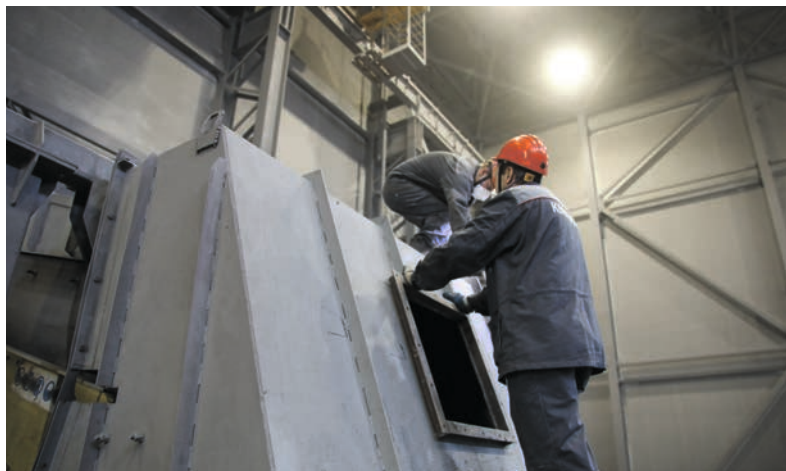
Работники РМЦ устранили неисправности грохота КСМД фабрики.
