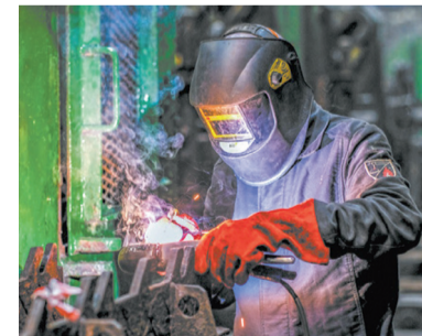
Ремонт прокатного стана обеспечит стабильную и надежную работу оборудования.
